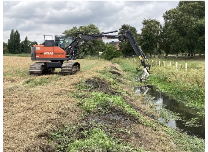
Mechanisierte Gewässerpflege mittels Bagger und Mähkorb (Foto WVV)
